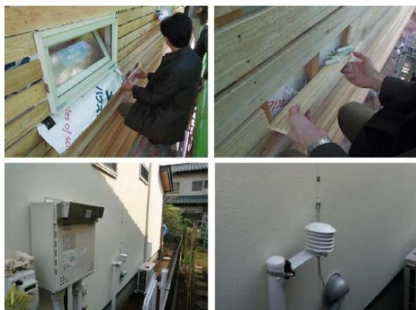
壁の中にもセンサーを埋め込み、温度と湿度を計測
