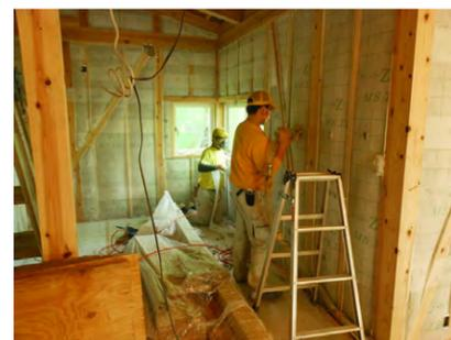
断熱材セルロースファイバーを吹き込む様子
